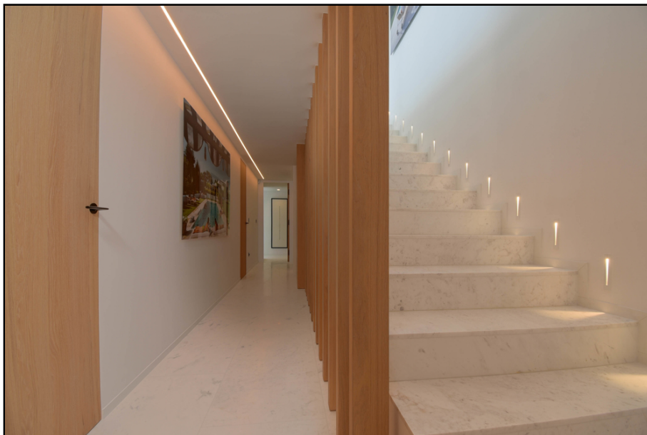
Marmortreppe mit Leuchtelementen
